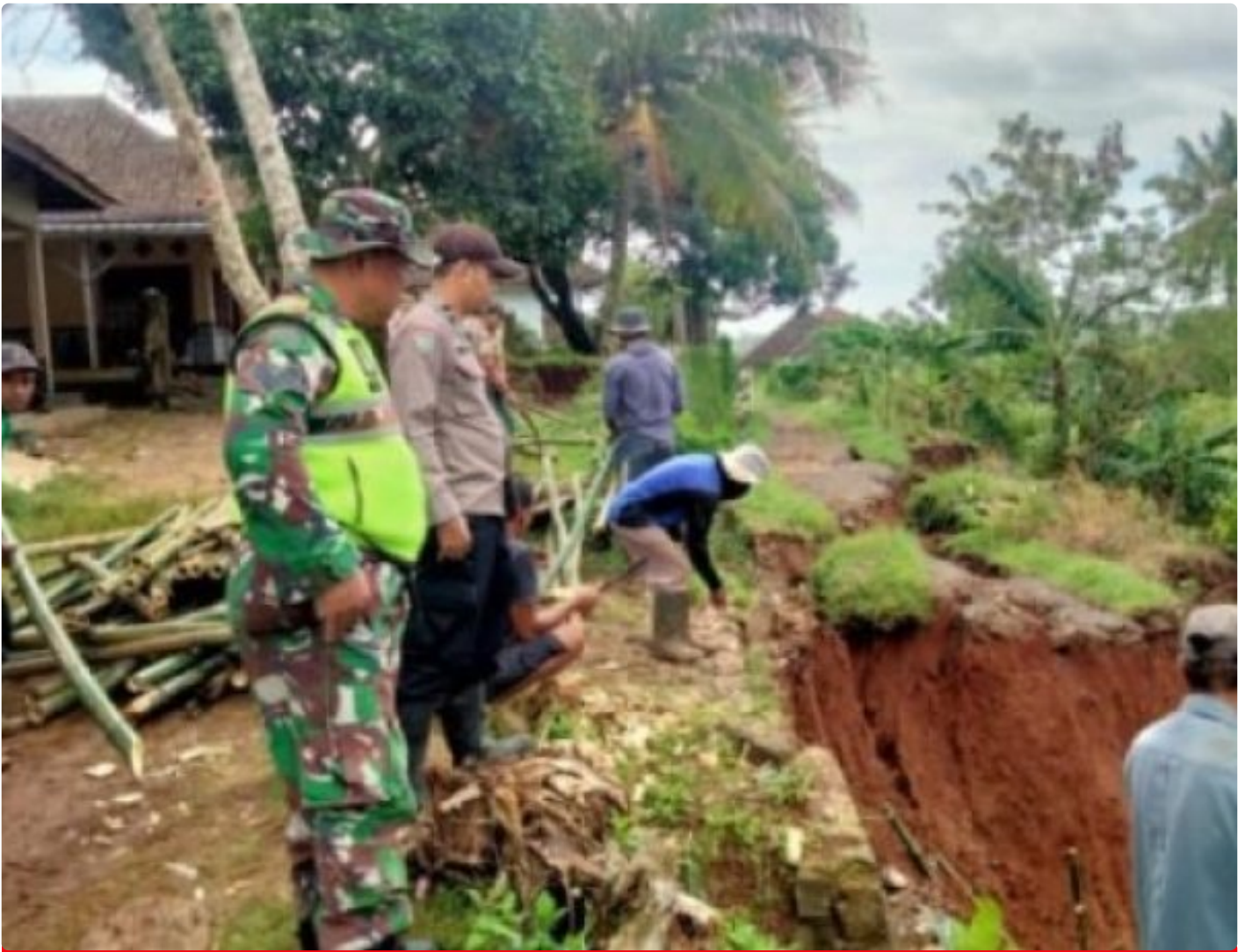
Monitoring dan Perbaikan Jalan Akibat Bencana Alam di Desa Tamanjaya, Kapolsek Ciemas: Antisipasi Bencana Lebih Besar
